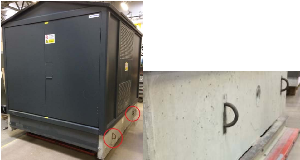
Bild 1 och 2. Visar Var lyftöglorna sitter på en elitstation.
